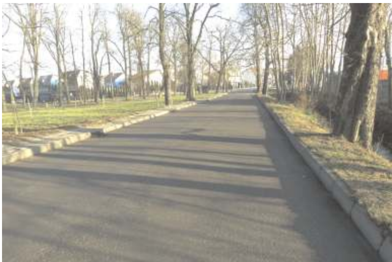
Nowa nawierzchnia ul. Lipowej
