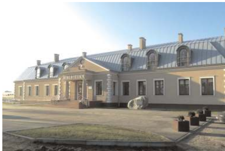
Biblioteka w budynku starego dworca PKP
