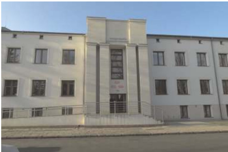
Front budynku Urzędu Miasta po remoncie
